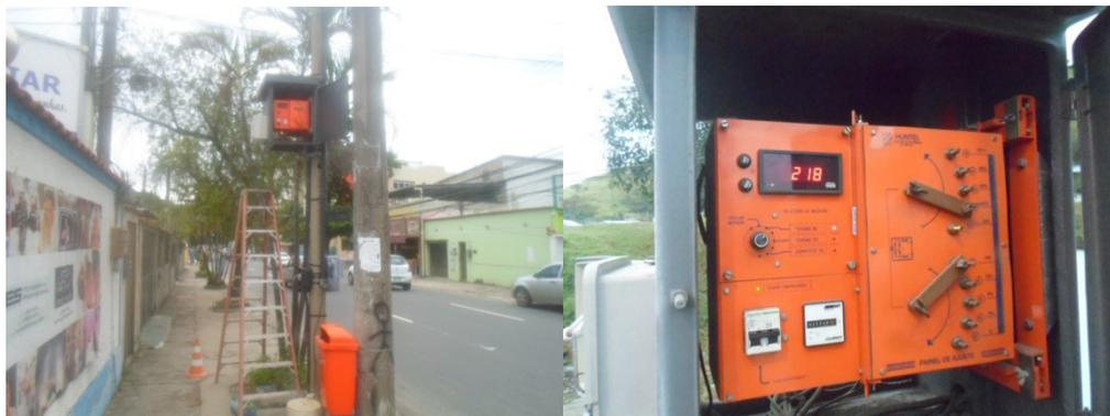
Figura 2 – Retificador de proteção catódica
